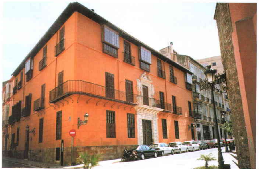
Rehabilitación de fachadas en el casco urbano de Málaga.
